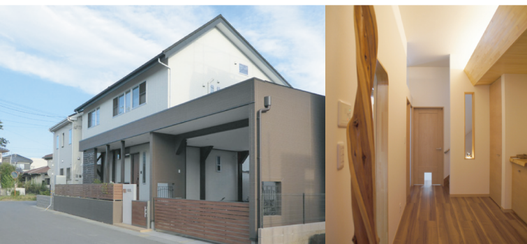
取手の家Ⅳ。間接照明とムク変木を玄関手すりにしたホール。
